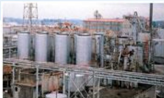
プラント工事
