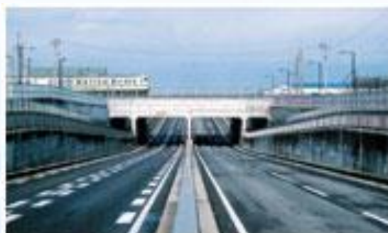
土木・建築工事
