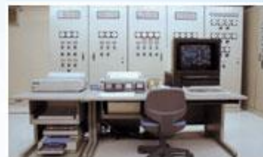
電気通信工事
