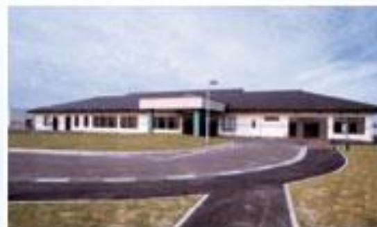
空調衛生工事
